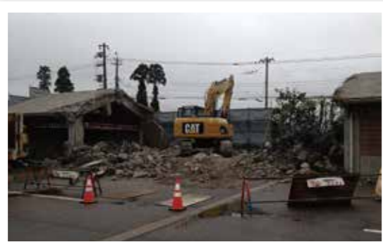
新館増改築事業による多門取り壊し工事
