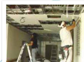
スプリンクラー設置工事
